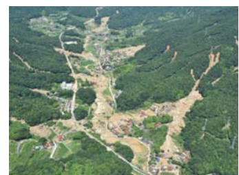
H30.7豪雨による 広島県呉市安浦町周辺の被災状況 （提供：国土交通省）
